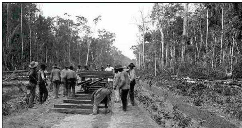
Trabalhadores assentando trilhos da EFMM
