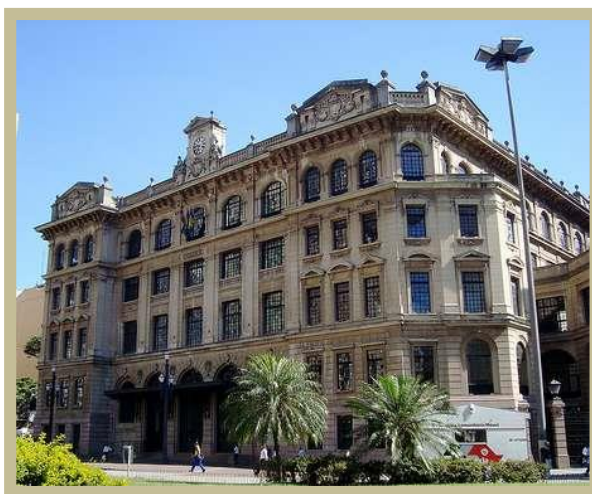
Prédio histórico dos Correios na cidade de São Paulo
